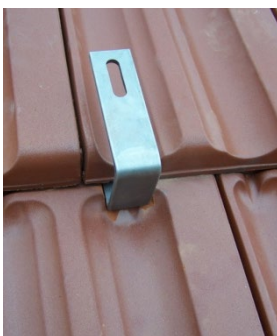
Abb. 3a) Bearbeitung der Dachziegel
