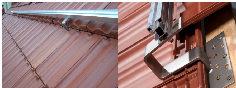
Abb. 3b) Querprofile auf dem Dachhaken und Schraubverbindung
